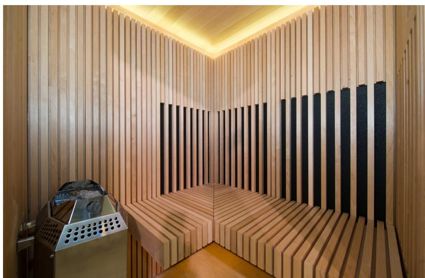
Les panneaux chauffants à infrarouges sont positionnés derrière les profils verticaux en aulne de première qualité.
